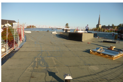
ARQUENAY (53) - Salle et cantine Architecte : A3 Architecture
