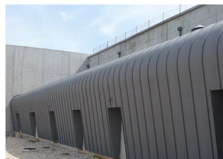
BLOIS (41) - Salle polyvalente Architecte : Atelier B.Penneron
