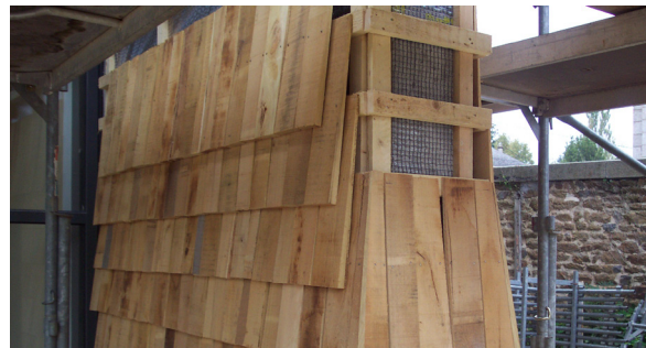
VILLAINES-LA-JUHEL (53) - Centre culturel Architecte : Atelier d'architecture
