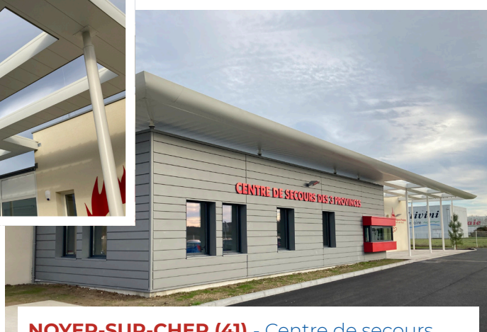
NOYER-SUR-CHER (41) - Centre de secours Architecte : Architecte Pur
