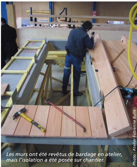
Les panneaux de toiture ont été complètement préfabriqués en atelier.
