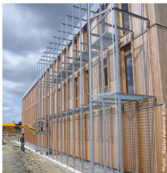
La structure métallique sur la façade nord recevra en été des plantes annuelles qui protégeront le bâtiment de l'ensoleillement direct.
