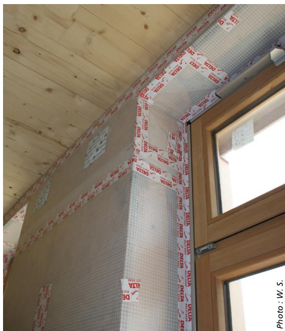
L'étanchéité à l'air a été l'une des principales préoccupations sur les trois chantiers.
