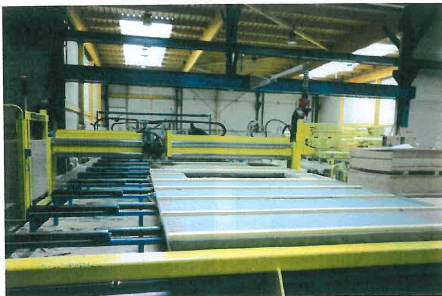
Les panneaux à ossature bois sont préfabriqués, isolés et fermés au sein de l'atelier destiné à l'ossature bois.
