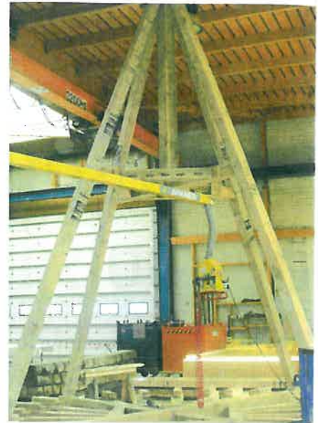
Cette charpente est prévue pour la réhabilitation d'un château.
