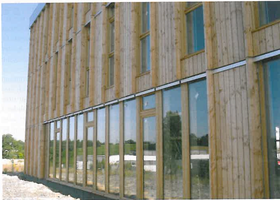
Les trois bâtiments à ossature bois comprennent un bardage vertical pour garantir l'écoulement des eaux.
